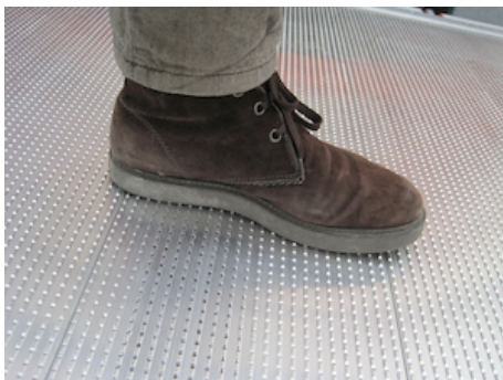
Plato de aluminio con perfiles orientados longitudinalmente [tipo V...], y estampado protector transversal antideslizante.
